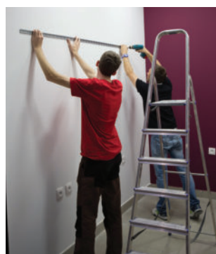
PHASE 1 Installation der Schiene.
