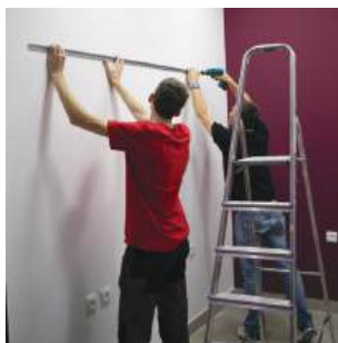
PHASE 1 FASE 1 Installation of the aluminium rail. Montaggio di binario in alluminio.
