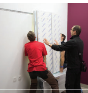
PHASE 2 Hanging the wall display onto the rail. Accrochage du présentoir mural sur le rail.
